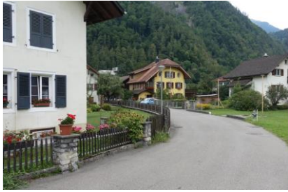
Abbildung 31: typische Sockelmauer mit Staktenzaun
