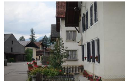
Abbildung 39: Staffelung der Bauten, hier Dreiecksbelymphonie Isenbolgen
