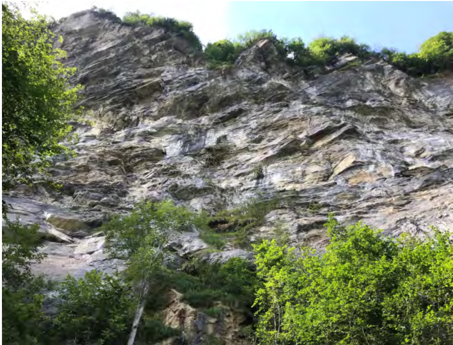
Abb. 3: Blick in die rund 100 m hohe senkrechte bis überhängende Felswand. Sie ist im unteren Bereich aus mergeligen Kalkschiefern und im oberen Bereich aus Quarzsandsteinen aufgebaut. Der Fels ist subhorizontal geschichtet und engständig geklüftet.
