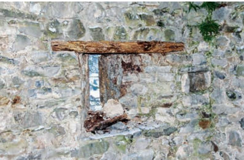
*Im Innern nagt der Zahn der Zeit, vor allem hat es zu viel Feuchtigkeit in den Mauern. Sichtbar wurde das zum Beispiel an einem gebrochenen Sturzbalken eines Schlitzfensters.*
