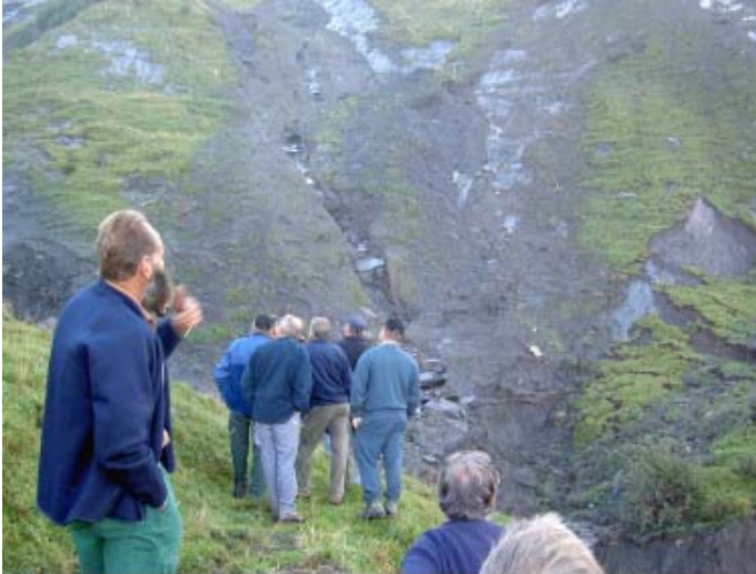
Abbildung: Gumpen 1800-1700 m.ü.M: Basis der Murgänge im Louwenen
